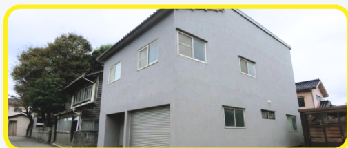
既存外壁に断熱材を貼り、塗り壁に大変身！
